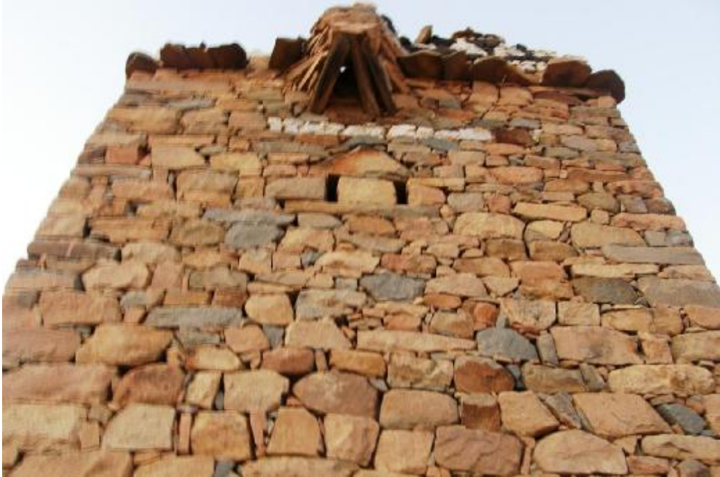
لوحة (٣٢) أطم (حصن) المهضم: تفاصيل للطرمة أو القوتالة التي تعلو المدخل.
