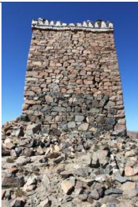
لوحة (٢٢) أطم (حصن) الغراب الشمالي: الواجهة الشمالية.
