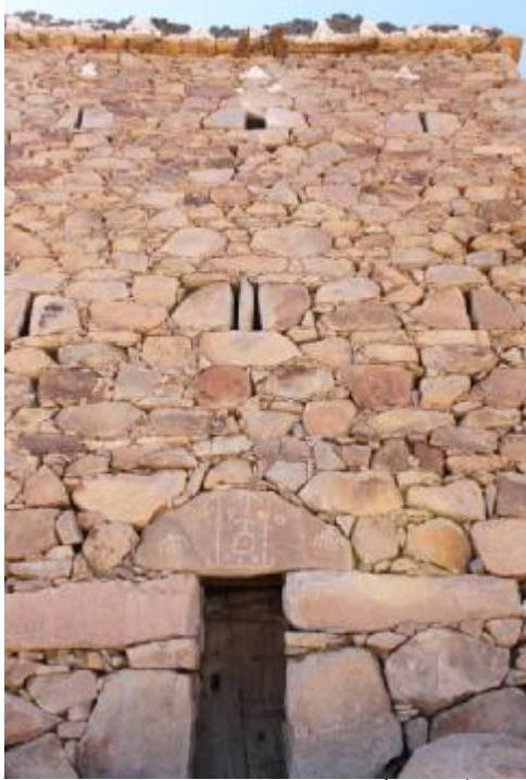
لوحة (٣) أطم (حصن) بن عميرة: فتحات الواجهة الشرقية.
