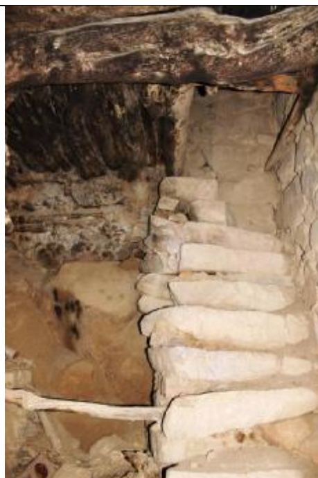
لوحة (١٦) أطم (حصن) الصبخة: السلم الداخلي.
