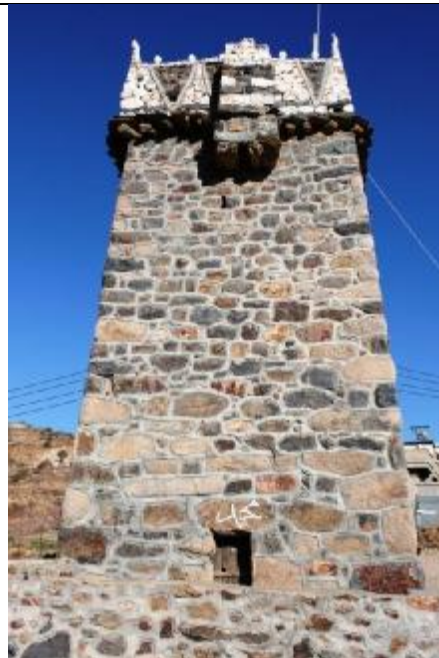
لوحة (٢٧) أطم (حصن) الكشمة: الواجهة الجنوبية بعد الترميم.
